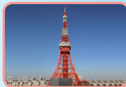
Torre de transmisión televisiva
