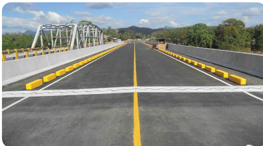
Construcción de carretera
