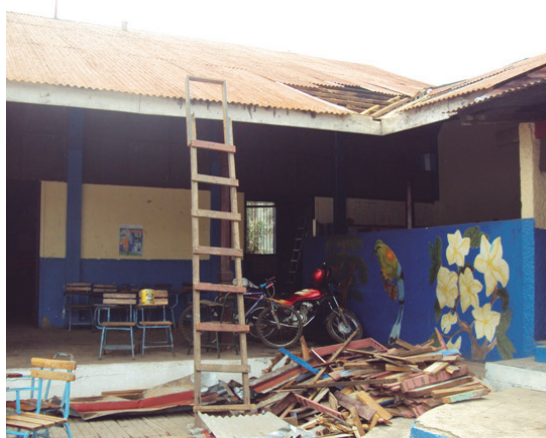
Reparación de escuelas
