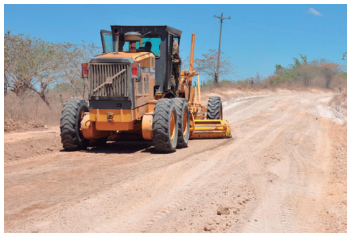
Reparación de caminos
