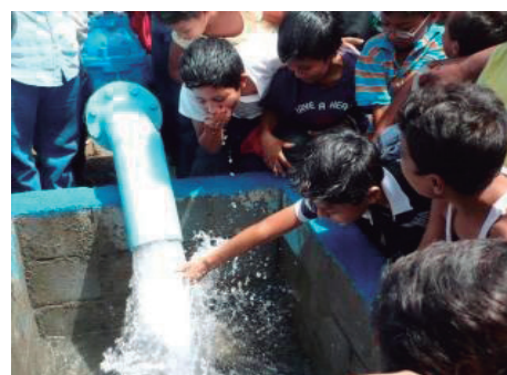
Abastecimiento de agua a las comunidades
