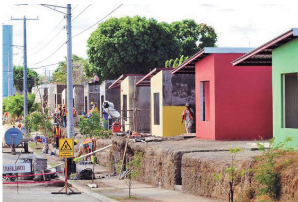
Proyecto de Viviendas financiado por el BCIE.
