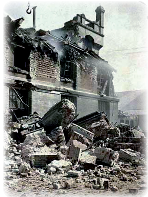
Destrucción debido a la guerra
