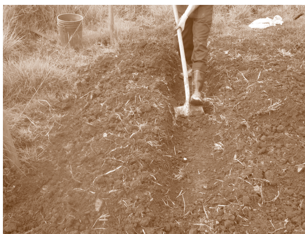
Fig. #30 Preparación del terreno
